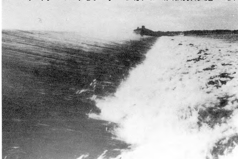
台風7号による増水で決壊寸前の溢流堤▶昭和34年8月14日午後2時ごろ(『大八洲開拓史』から)
