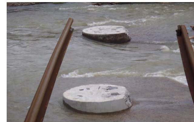
P2～P4折損面下流側に損傷があり転動破壊
