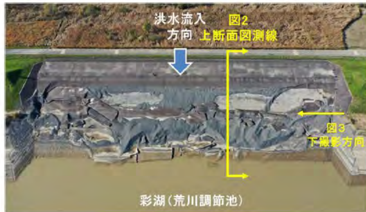
図-4 斜面上の跳水による局所的水面低下と揚圧力作用
