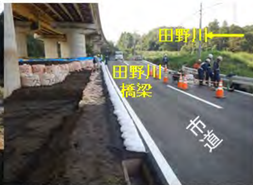
隣接する市道の状況 (舗装打替え済み)
