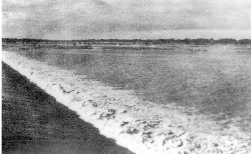
台風22号による溢流堤完成後最初の溢水▶昭和33年9月26日(『大八洲開拓史』から)
