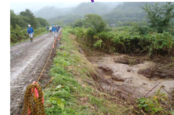
破堤箇所下流にも越水跡
