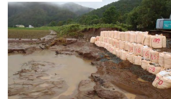
破堤箇所の状況
