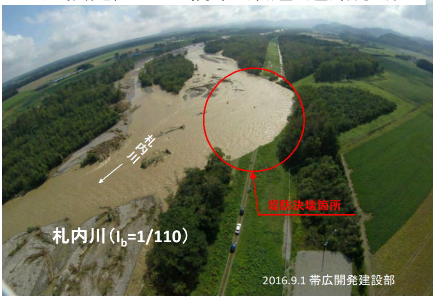
破堤後の状況
