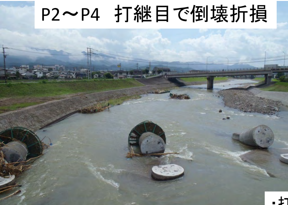
P2～P4折損面下流側に損傷があり転動破壊
